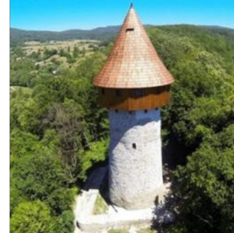
Cernat (Co. Covasna) Broken Tower
