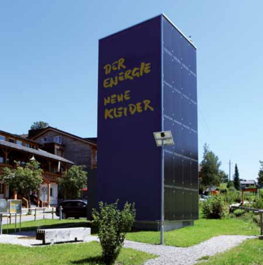
Umbau einer Trafostation zu einem Solar-Schaukraftwerk als Ausgangspunkt für den Energieweg in Langenegg, Vorarlberg (fink thurnher architekten, 2006)
